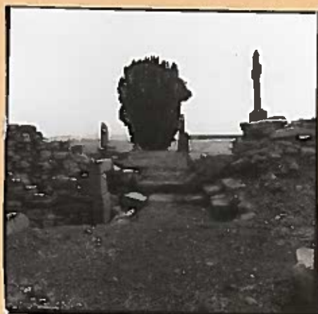
S. wall, (inner) door
